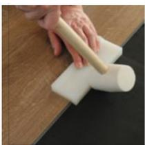
Rigid wird an der Längskante passend eingewinkelt. Das Ende mit der überstehenden Lippe wird dabei passgenau über die bereits liegende Diele gelegt und durch ein paar dosierte Schläge mit dem Gummihammer eingerastet. Damit die Profile zuverlässig ineinandergreifen wird die Längsverbinding mit dosierten Schlägen mit dem LOC-n-FIT Schlagklotz und Gummihammer vollständig geschlossen.
